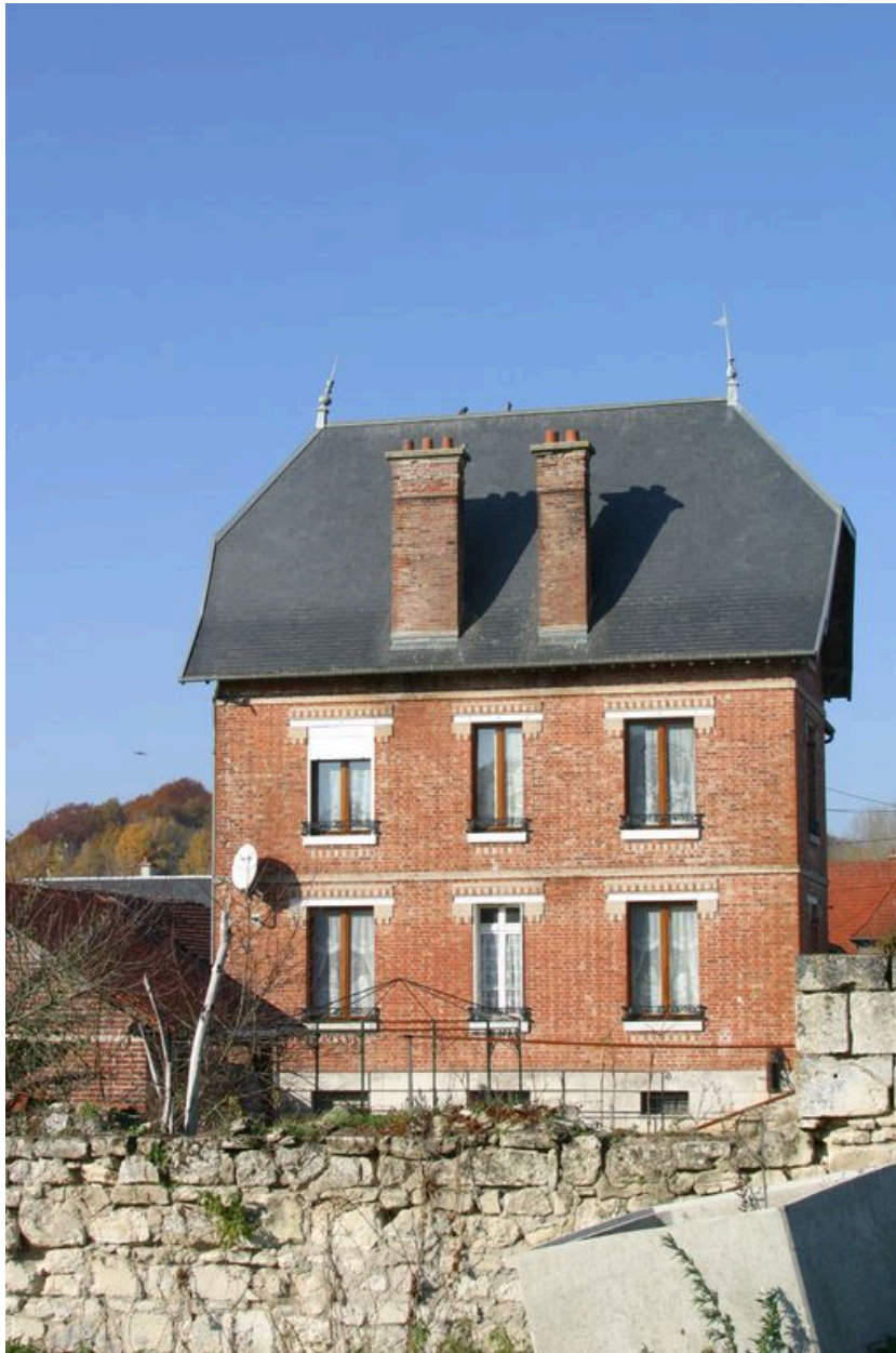
Vue générale de la façade postérieure.
