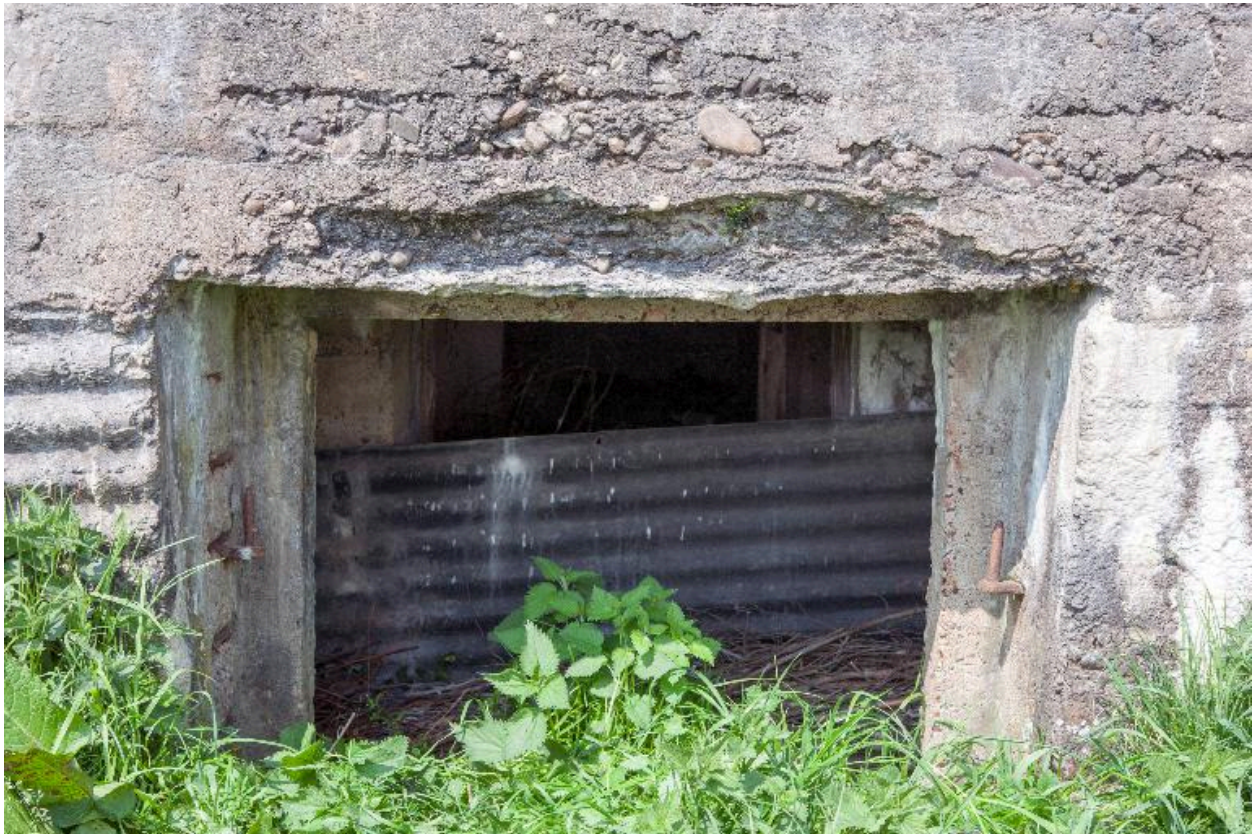
Elévation sud, entrée centrale
