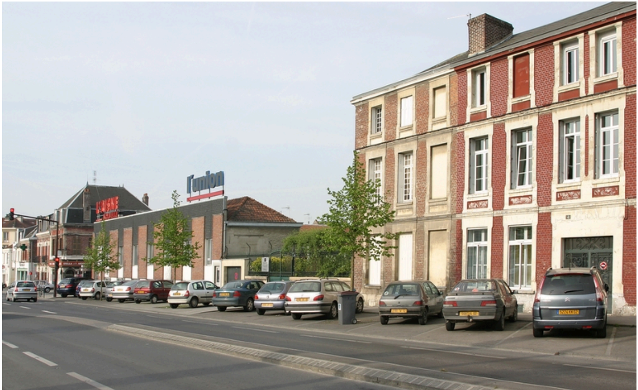
Logement patronal (à droite) et ateliers, en bordure du boulevard Henri-Martin.
