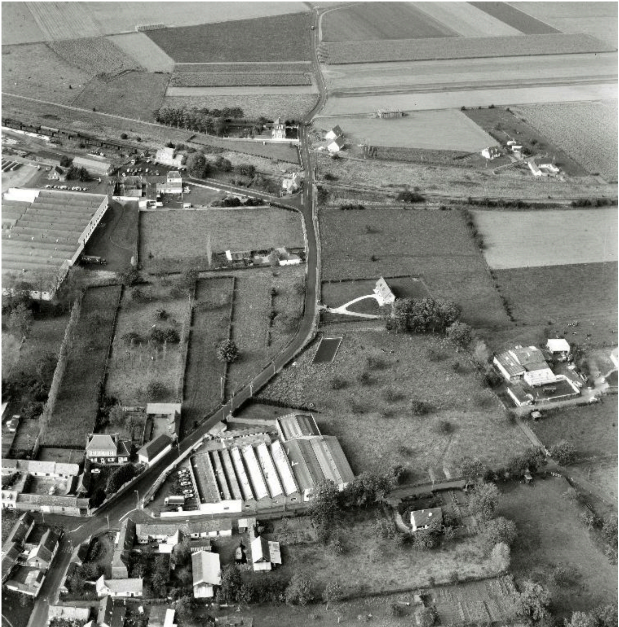
Vue aérienne de la nouvelle usine depuis le sud
