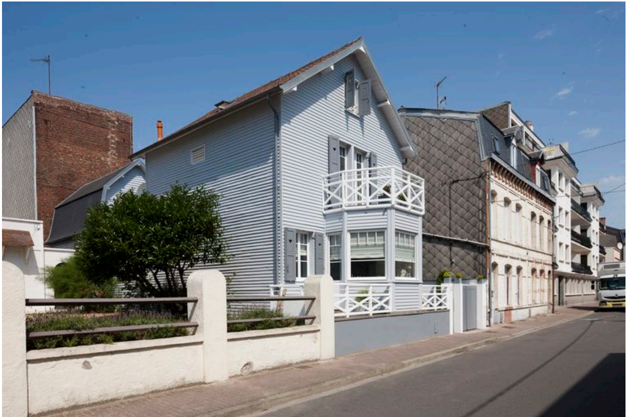
Vue générale de trois quarts du chalet en 2013.
