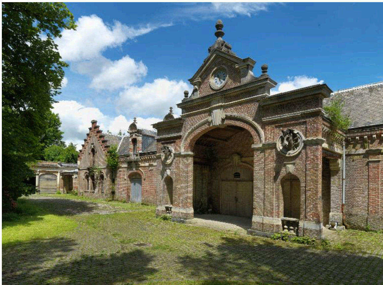
Les communs, vue extérieure des écuries.
