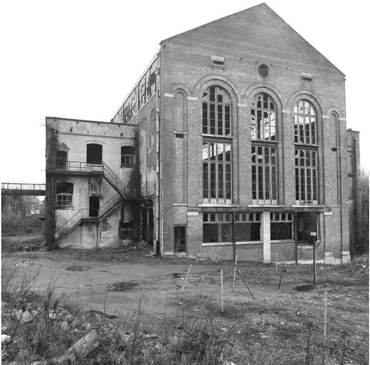
Vue générale de la centrale électrique de l'usine Vallourec en 1990 avant sa destruction.
