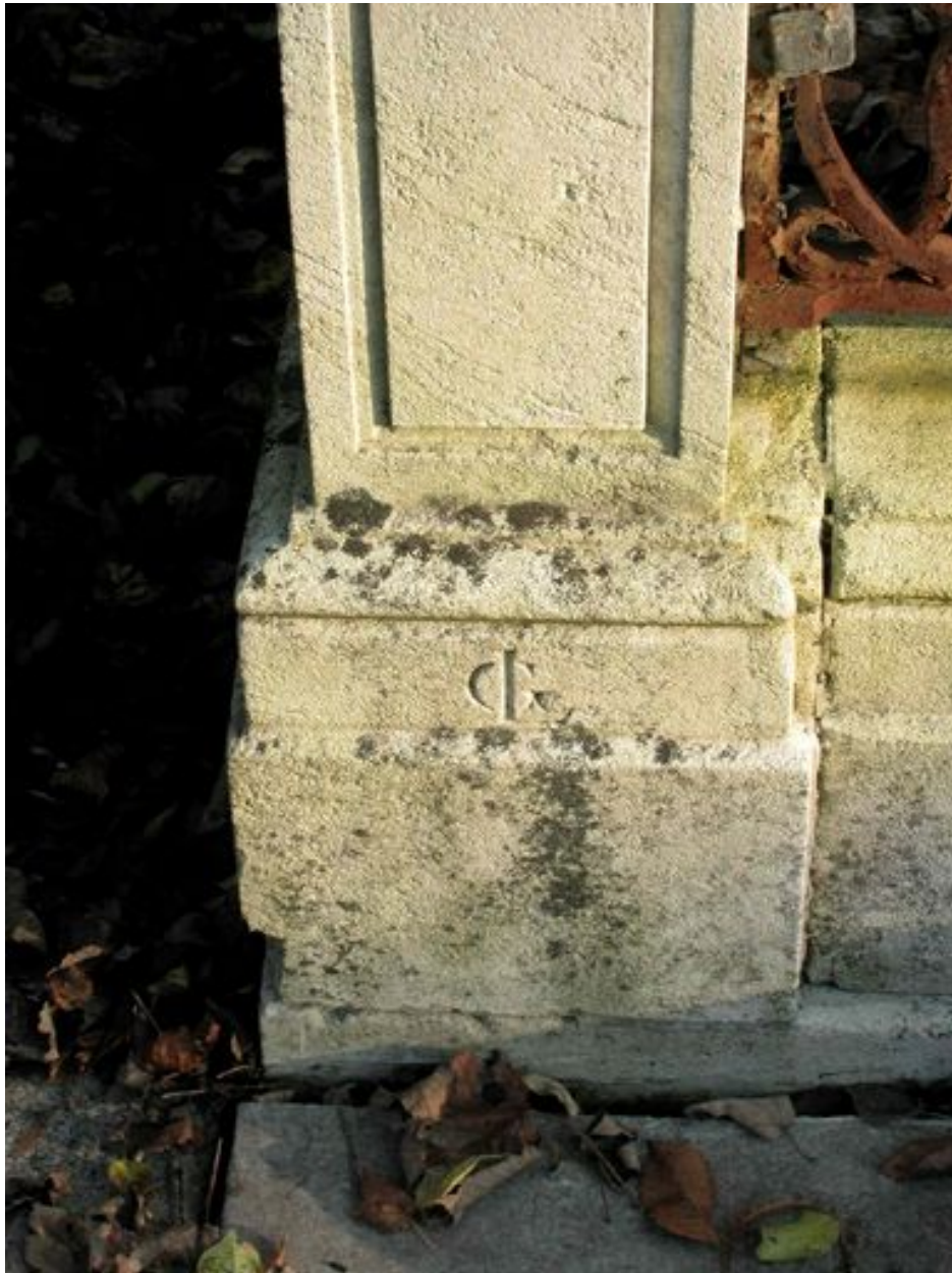
Détail du pilier gauche de la clôture.
