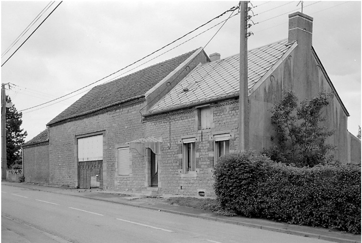
Vue générale de la ferme située 3 Grand Rue.
