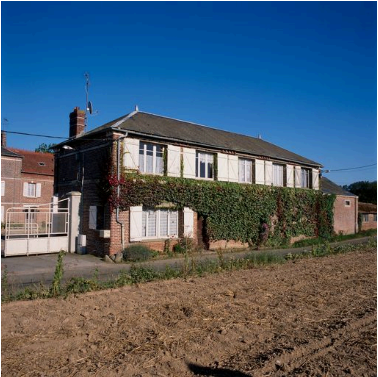
Façade sur rue des anciennes écuries converties en logement.
