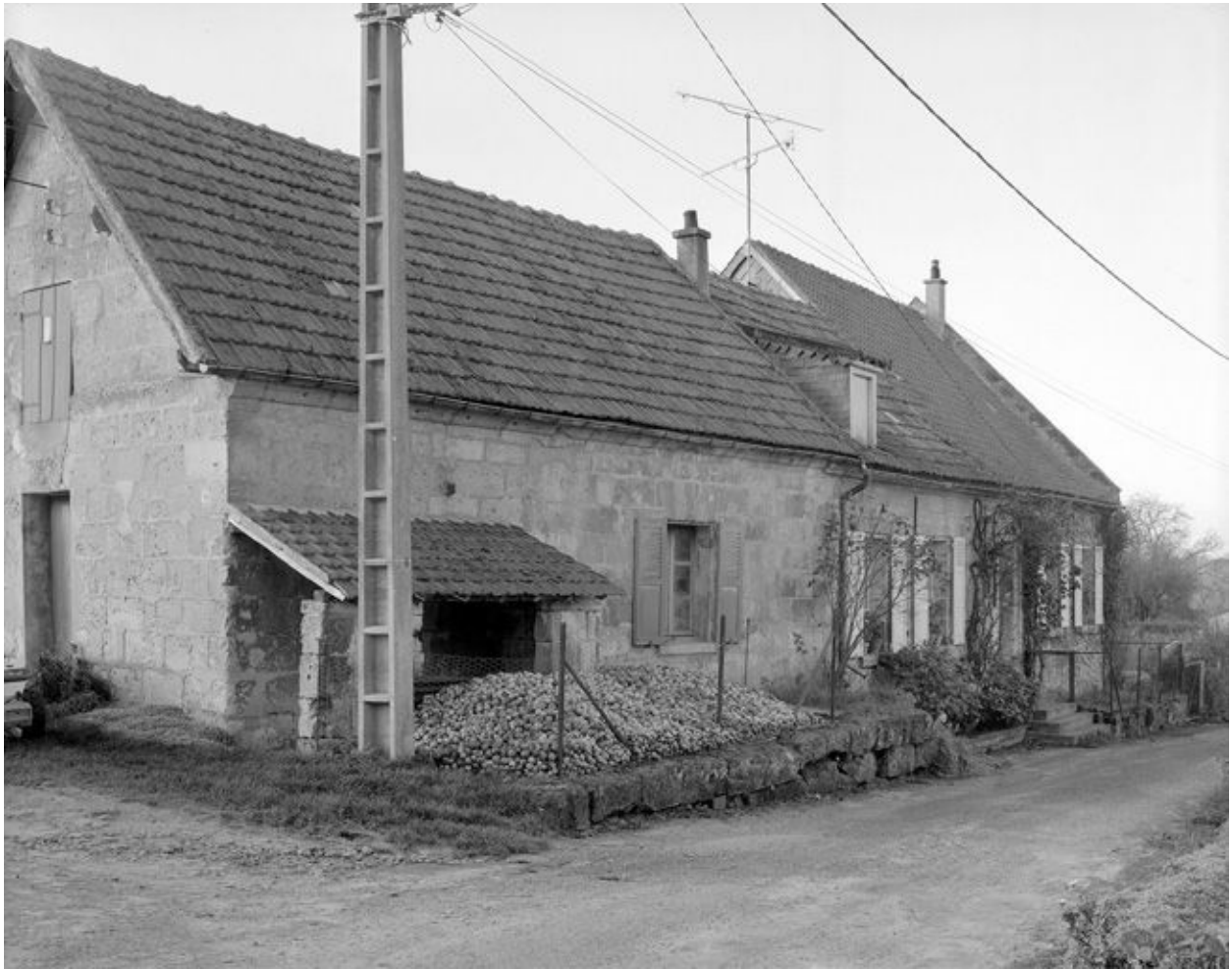
Logis. Vue générale.
