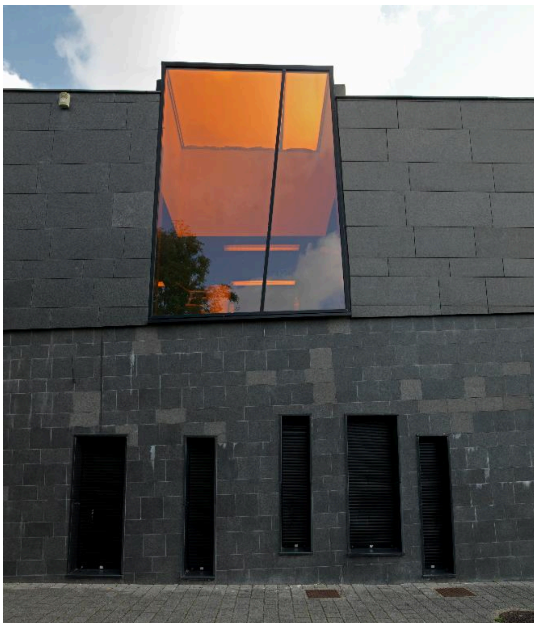
Détail des jeux d'ouvertures asymétriques de la façade d'entrée.
