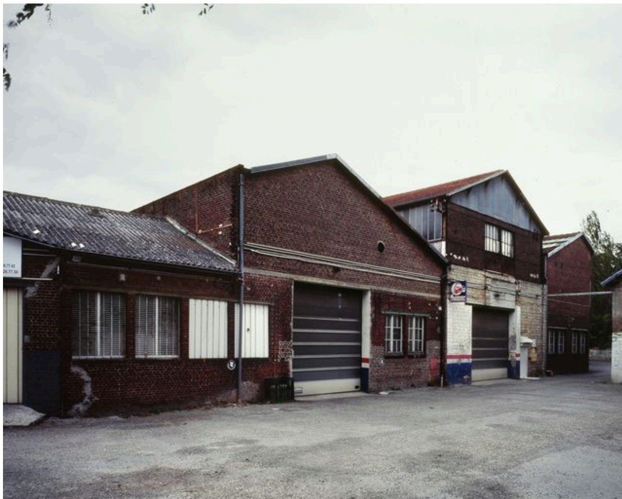
Les façades des ateliers de fabrication à l'ouest.
