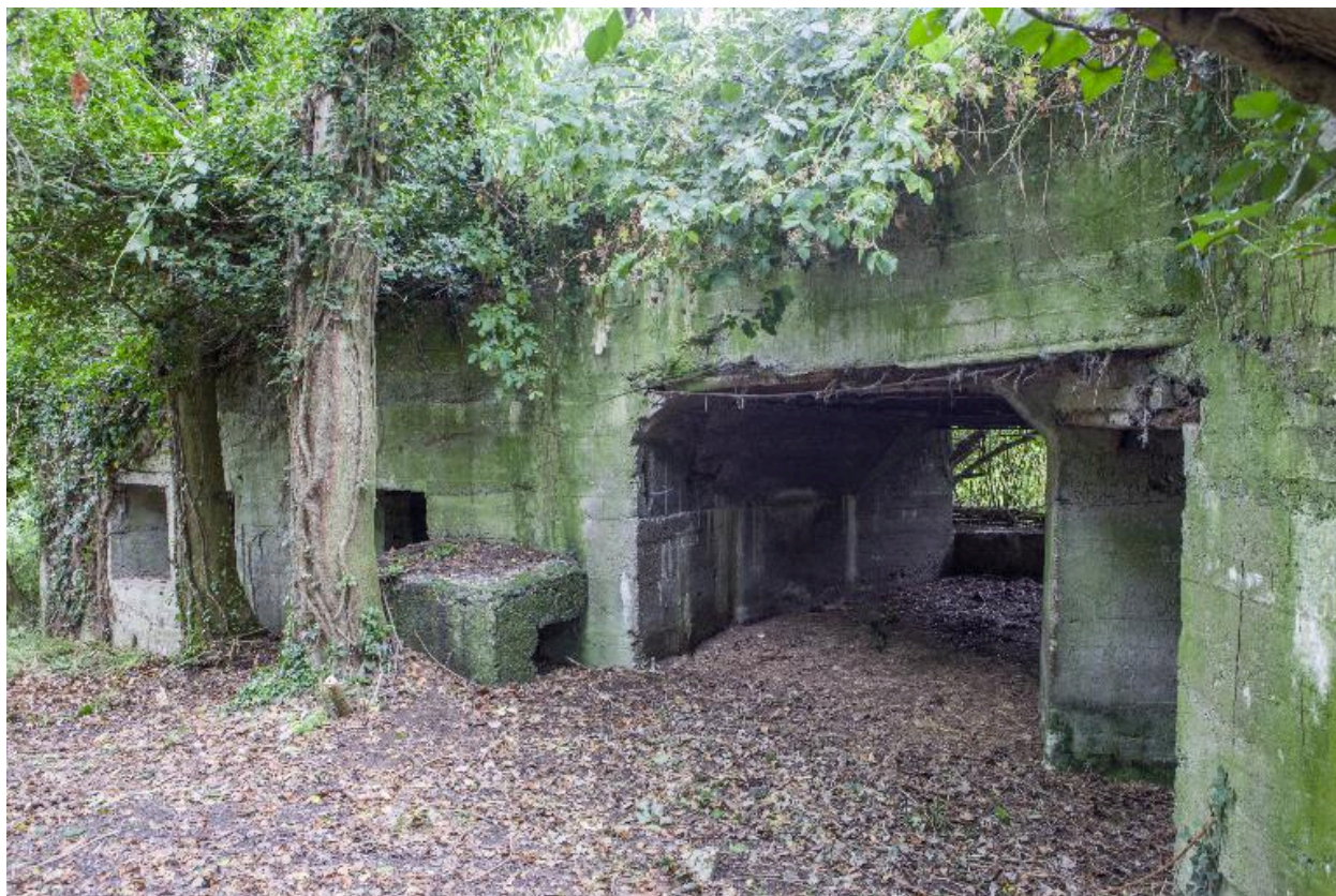
Chambre de tir en enfilade
