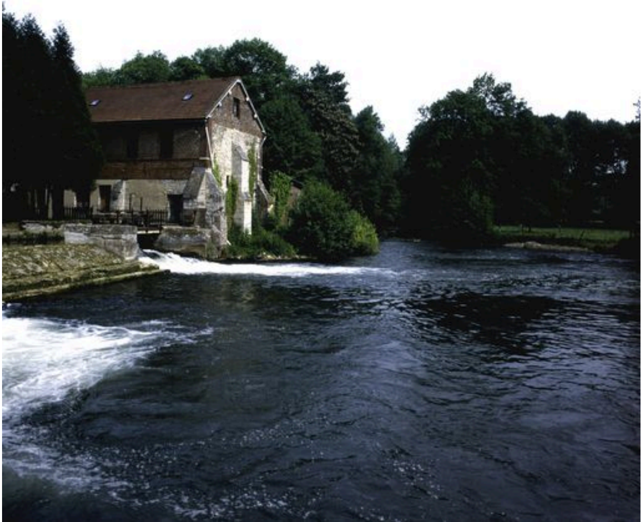
Vue d'ensemble du moulin à farine dit d'Achon.
