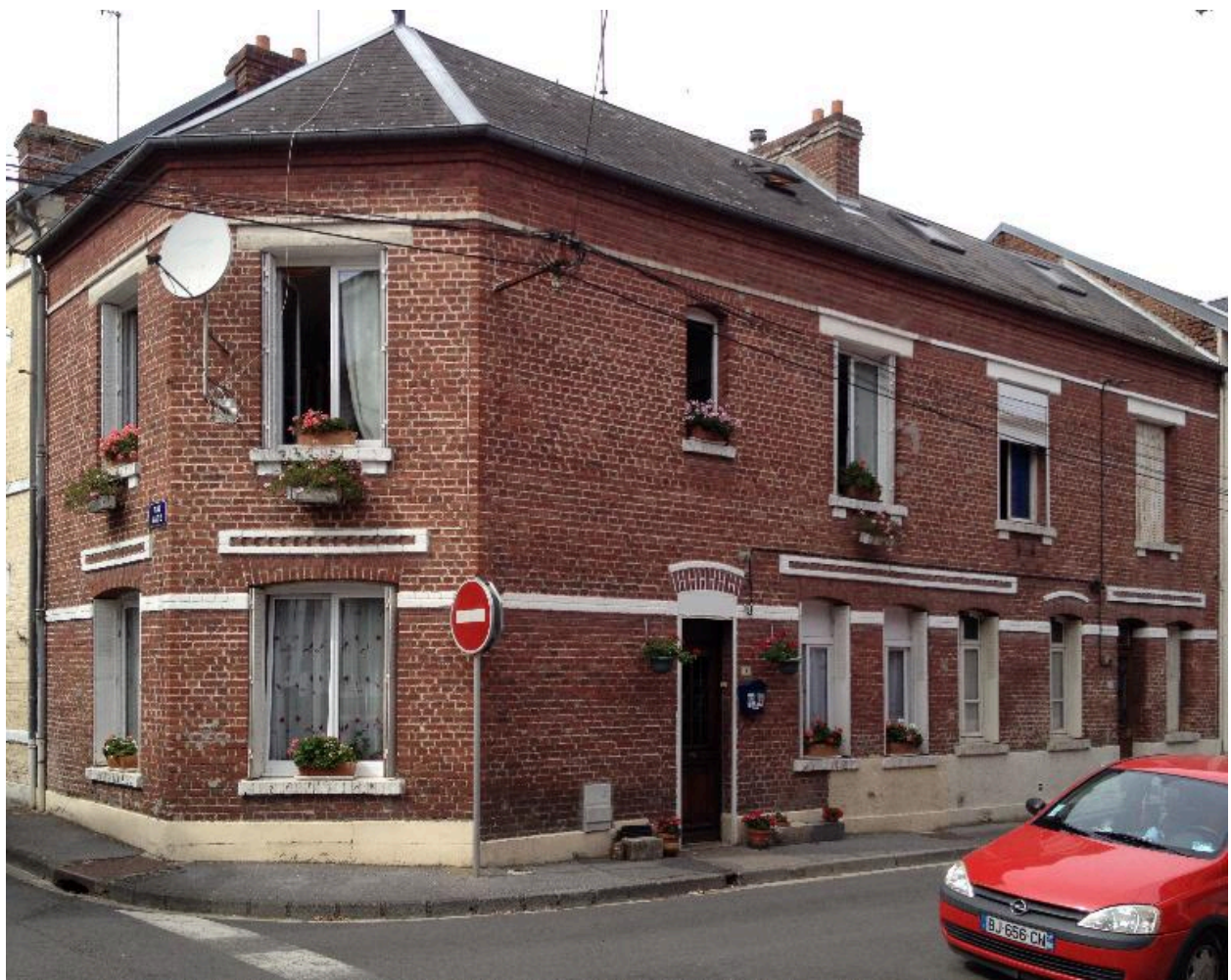
Maison d'angle, 7 et 9 rue du Grenier-à-sel.
