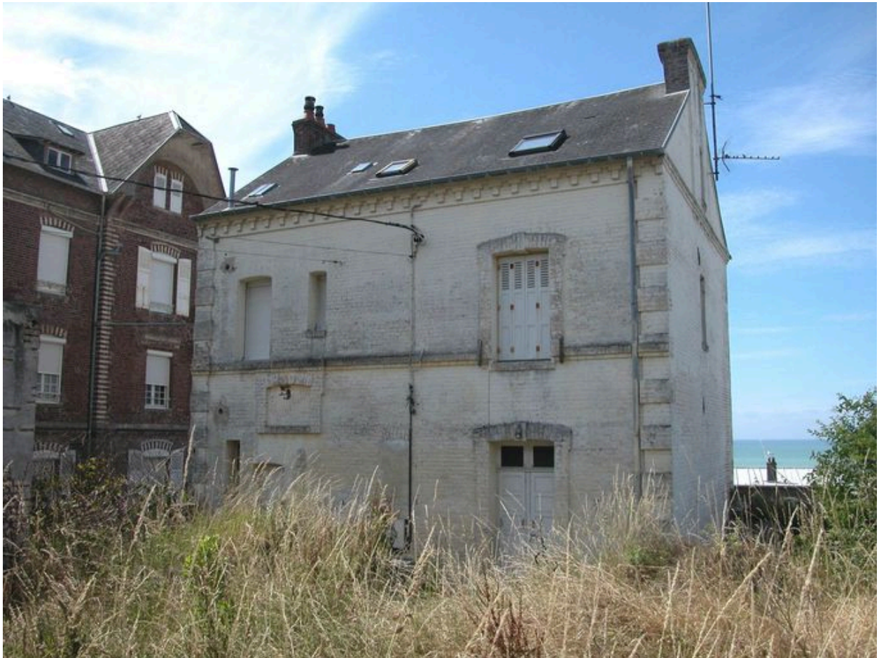
Elévation postérieure depuis la rue Gros.
