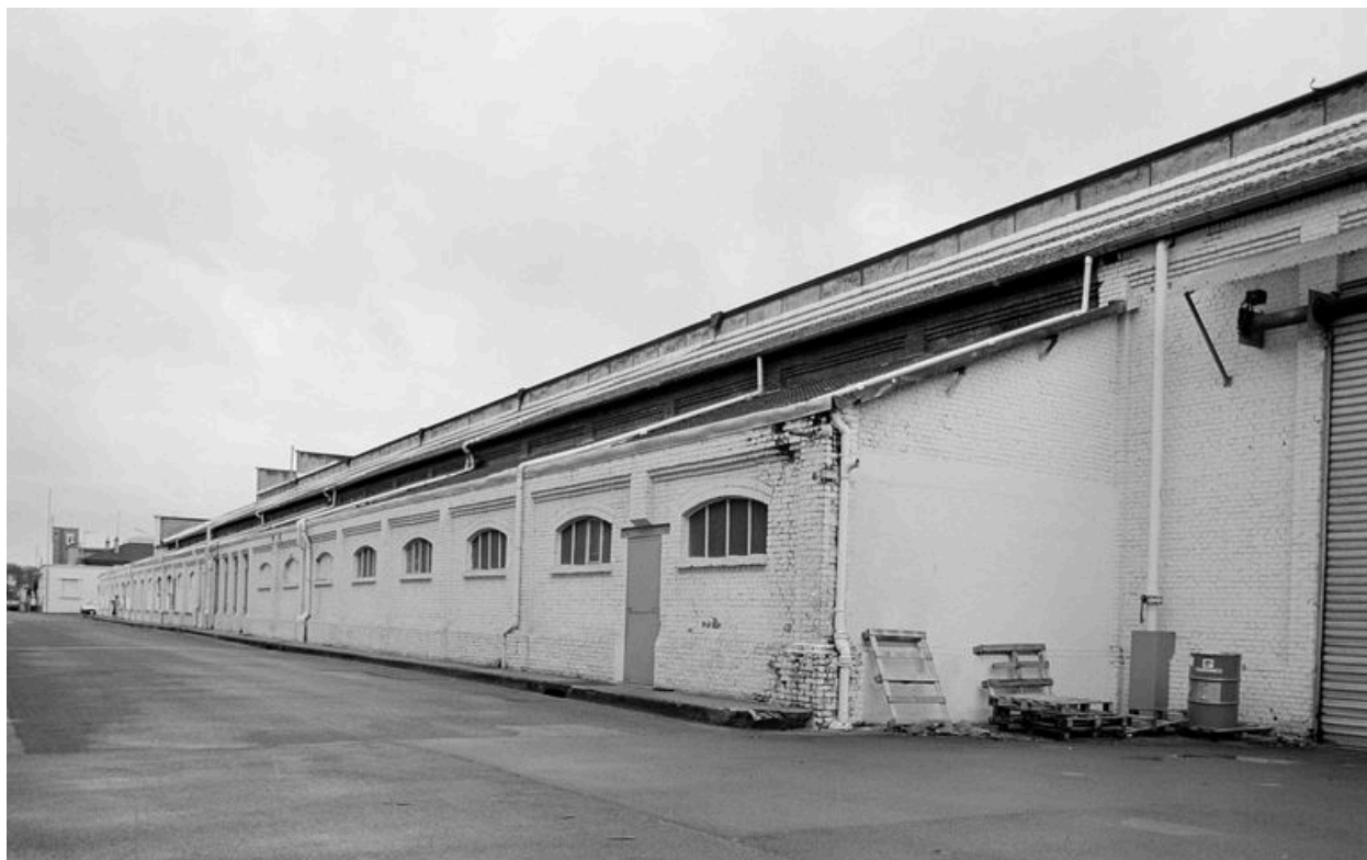
Atelier de fabrication principal : flanc sud.
