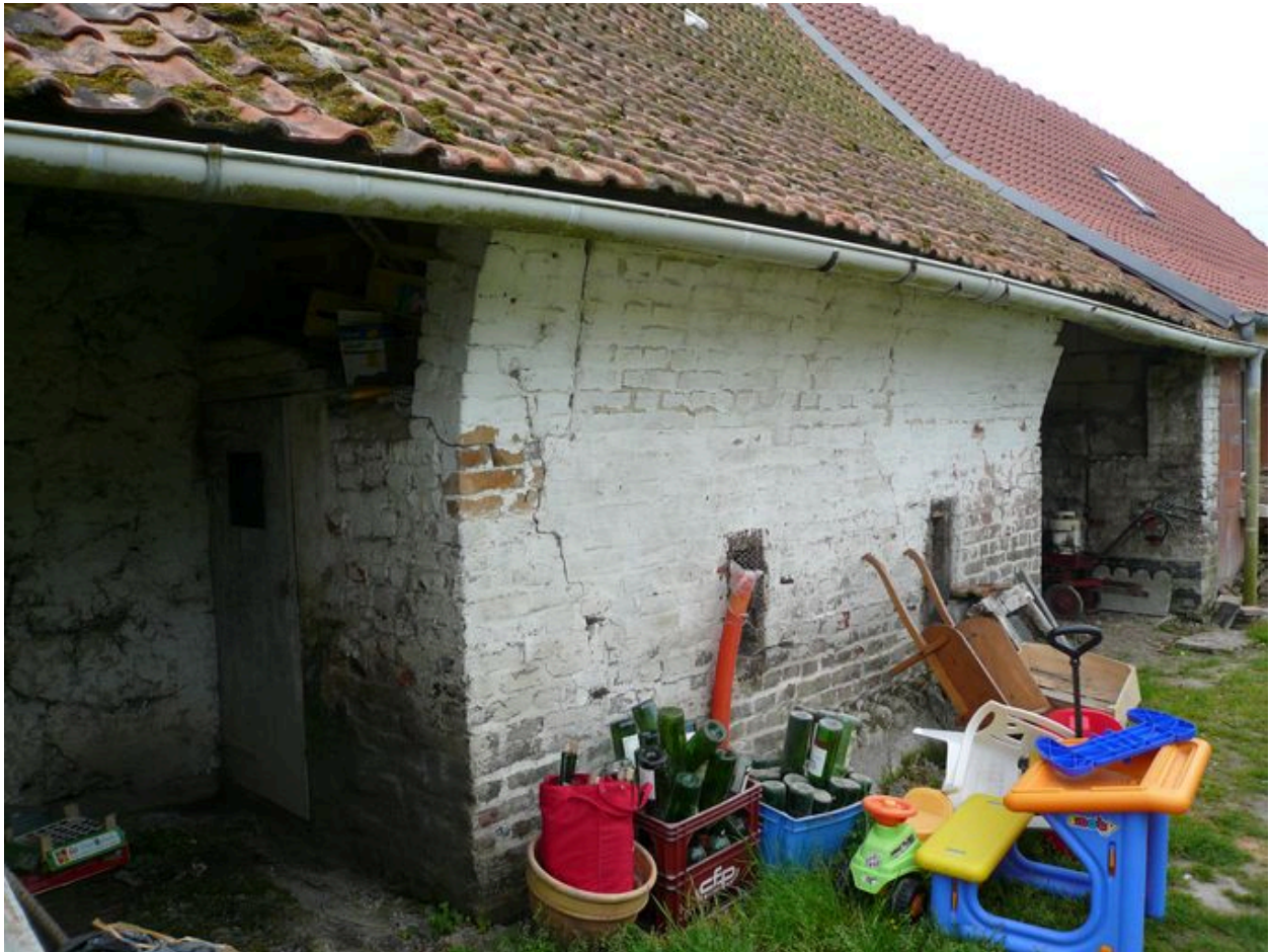
Détail de la cave semi-enterrée dite plat-cul.
