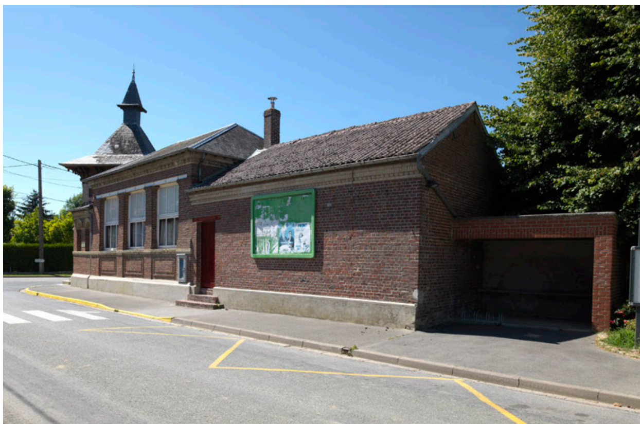
Vue des façades, rue d'Enfer.
