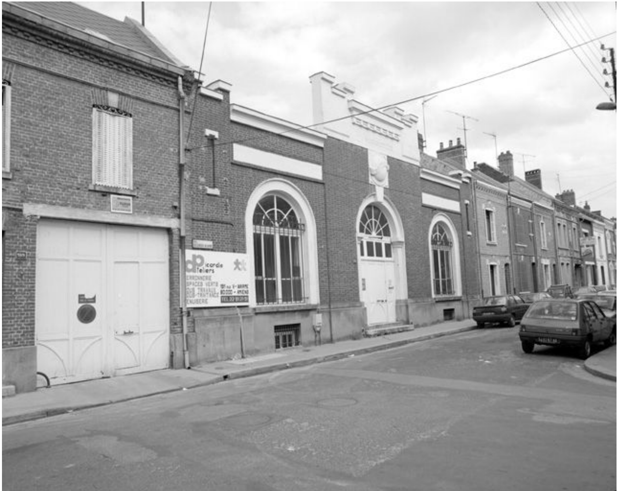
Vue du magasin-réception (élévation antérieure).
