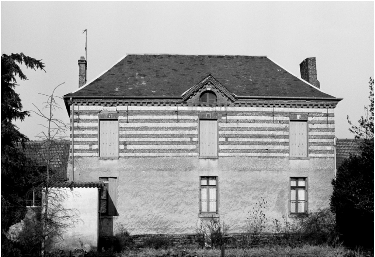
Façade postérieure du logis.
