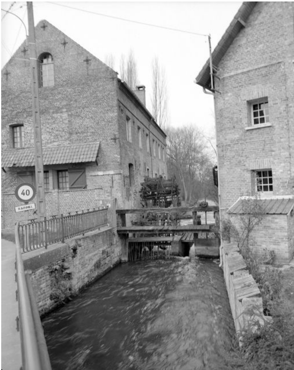
Atelier de fabrication, roue hydraulique verticale, vanne.
