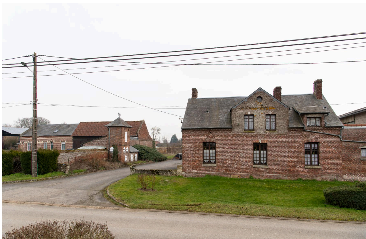
Ferme à cour de la famille Matrot, n°331 rue des Marronniers, vue depuis le nord.
