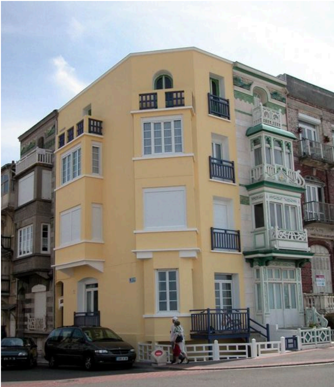
Vue d'ensemble depuis l'esplanade.
