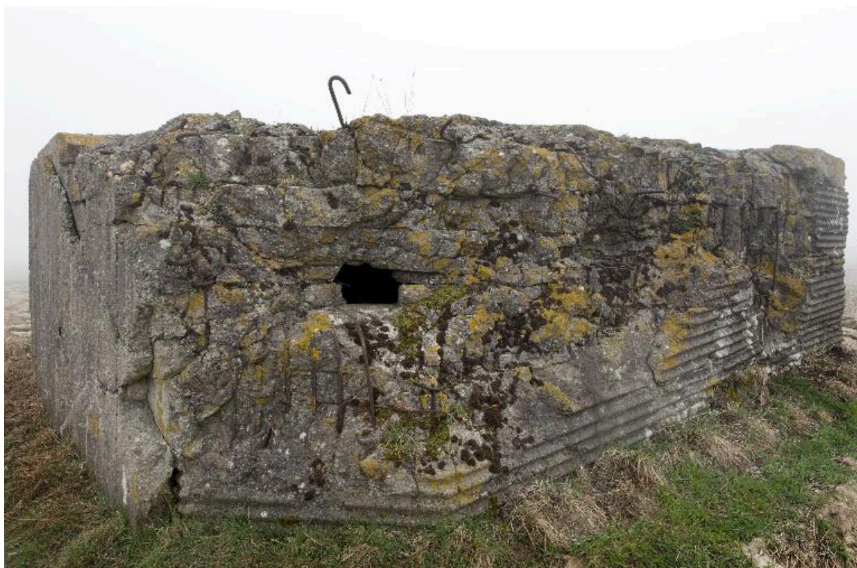
Poste d'observation, vers le nord-est
