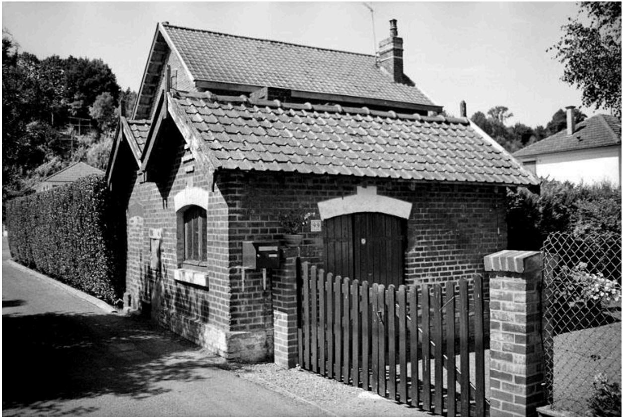
Vue, depuis la remise, de la maison N°99, rue Alfred Migrenne.
