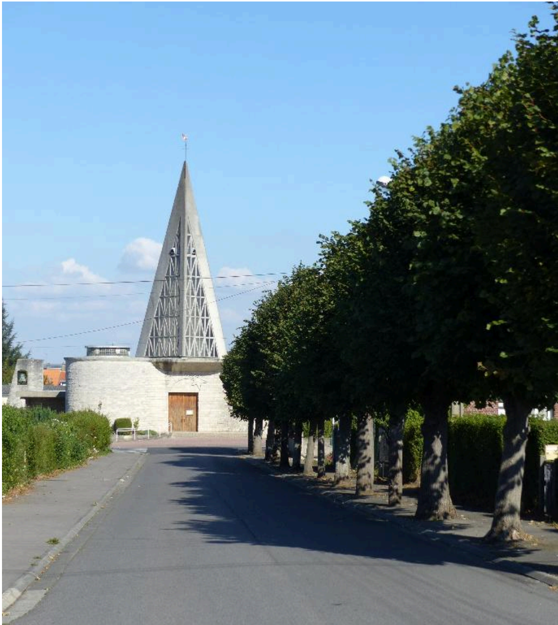
Vue de situation, dans la perspective de la rue du Général-De Gaulle.
