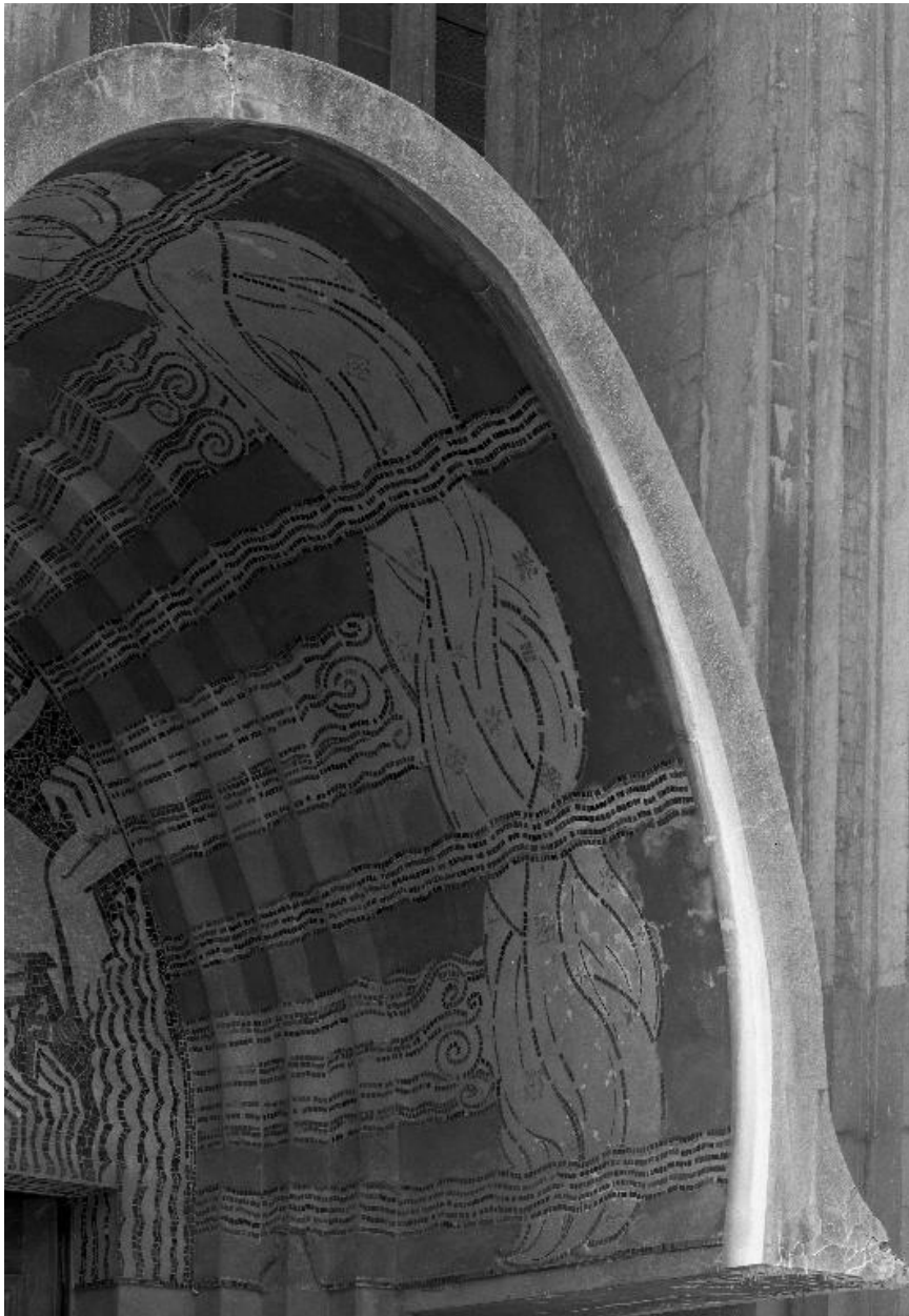
Porche, détail de l'intrados de l'auvent.
