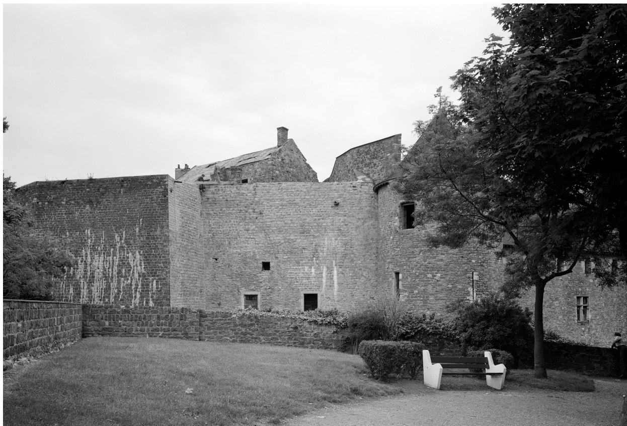
Vue du rempart de la façade nord.
