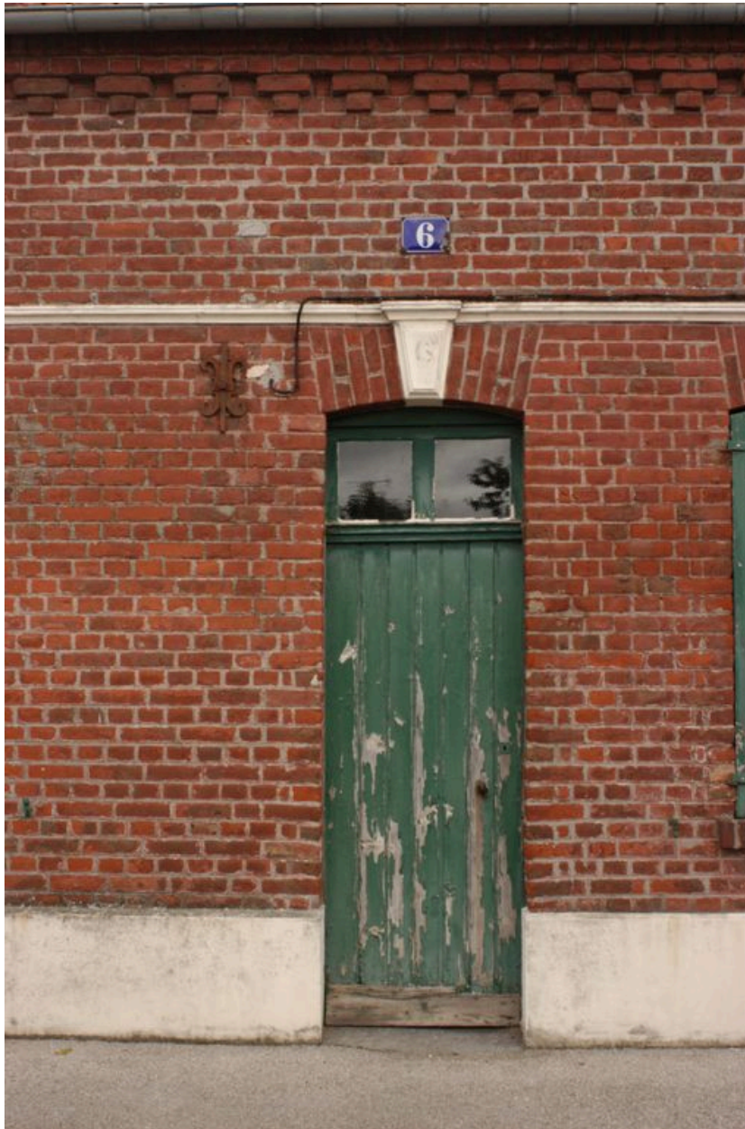
6 rue Saint-Pierre, vue de détail sur la porte du logement.
