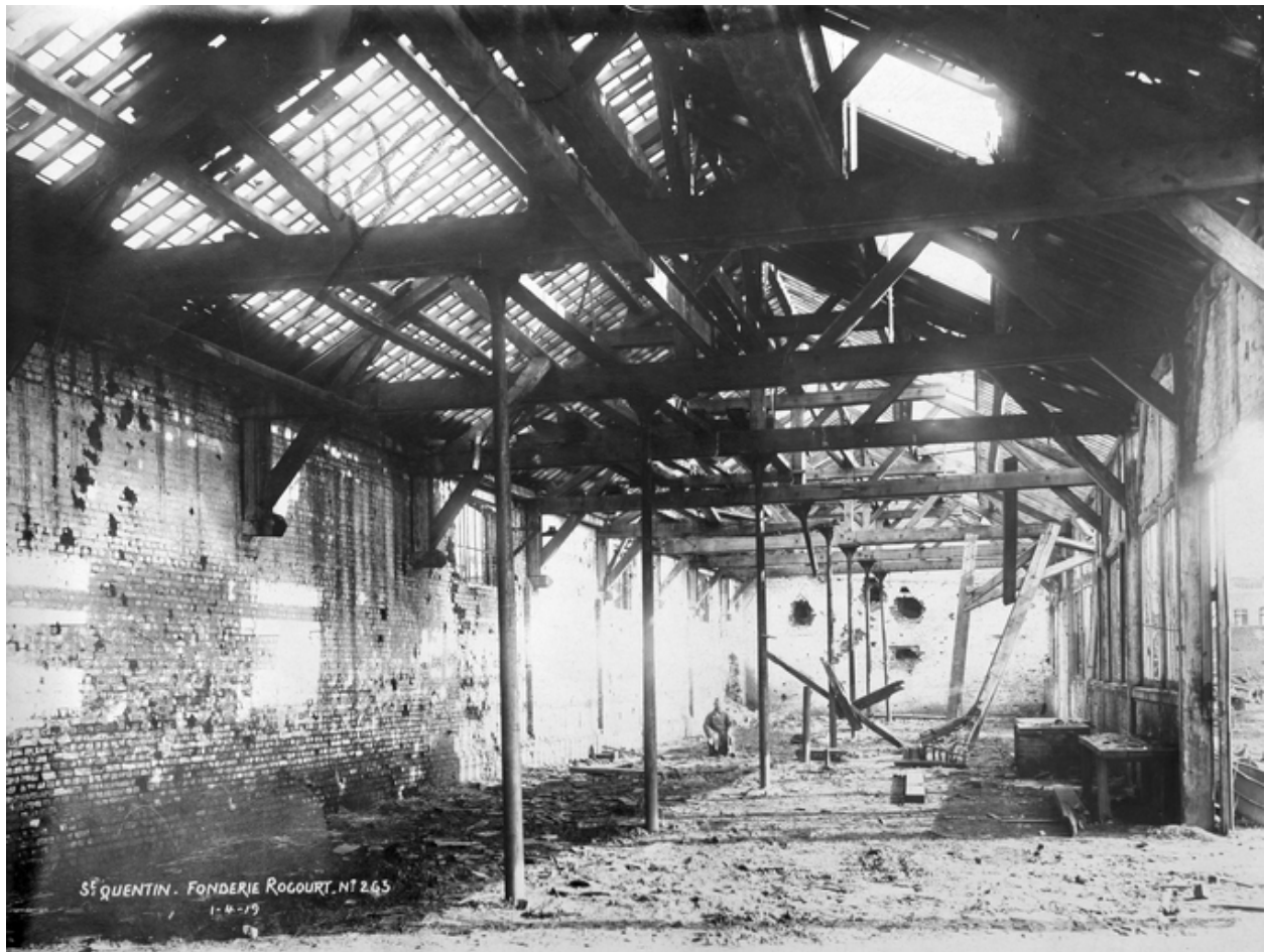
L'atelier de construction mécanique, 1919 (AD Aisne).
