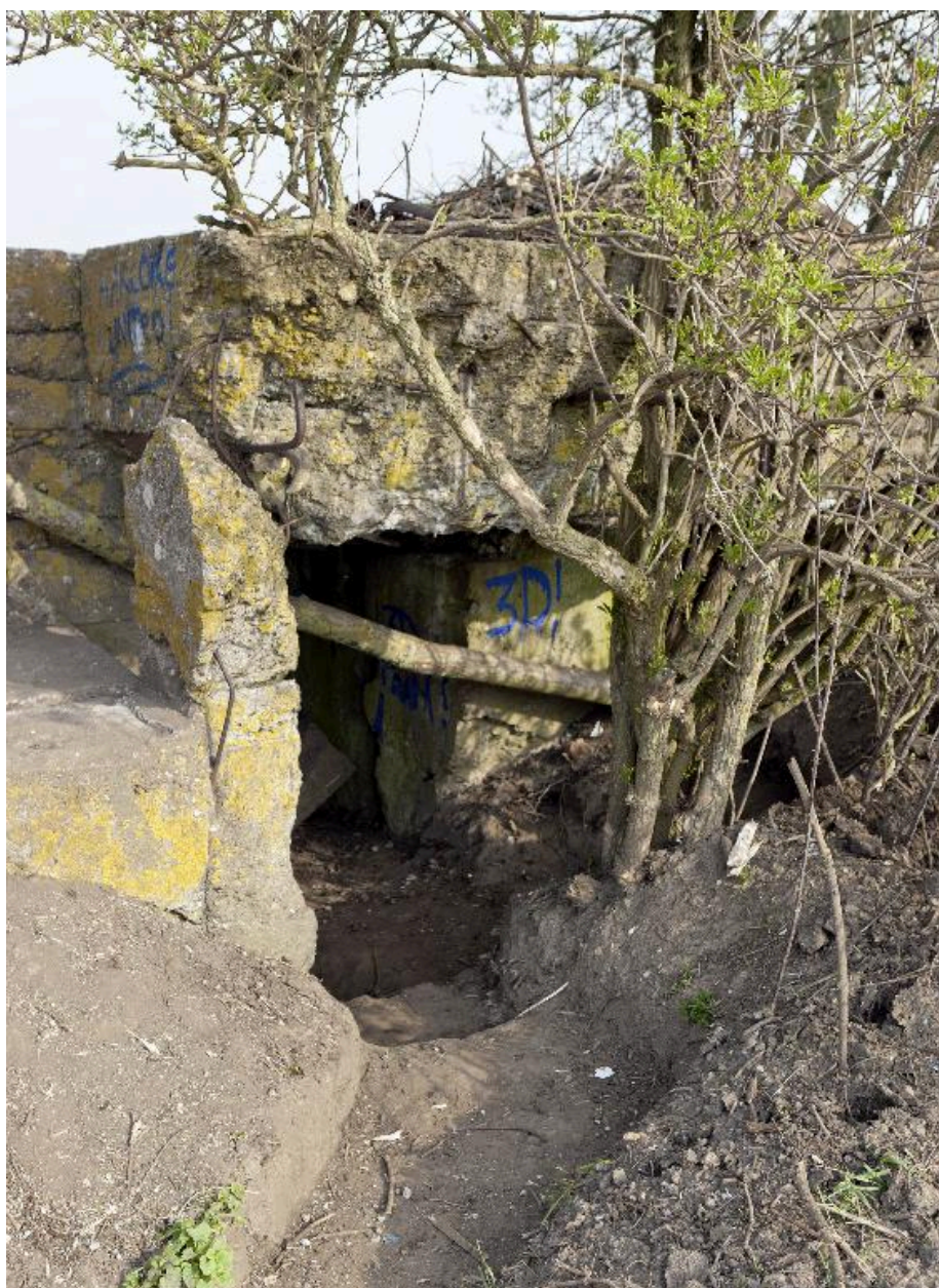
Elévation sud, accès à l'édifice
