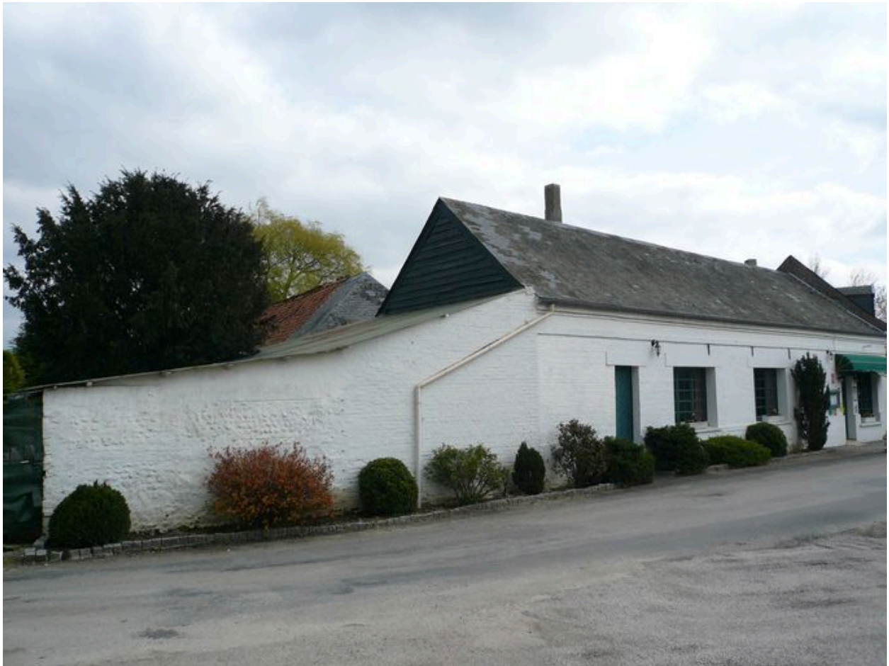
Vue des étables à cochons dans le prolongement du logis.
