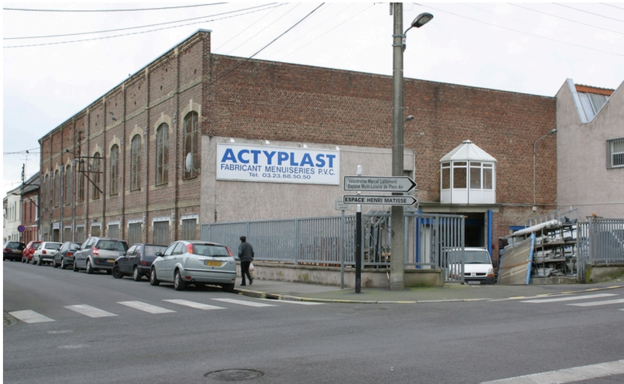
Vue des ateliers construits en 1911 à l'angle des rue Denfert-Rochereau et du Colonel Fabien.
