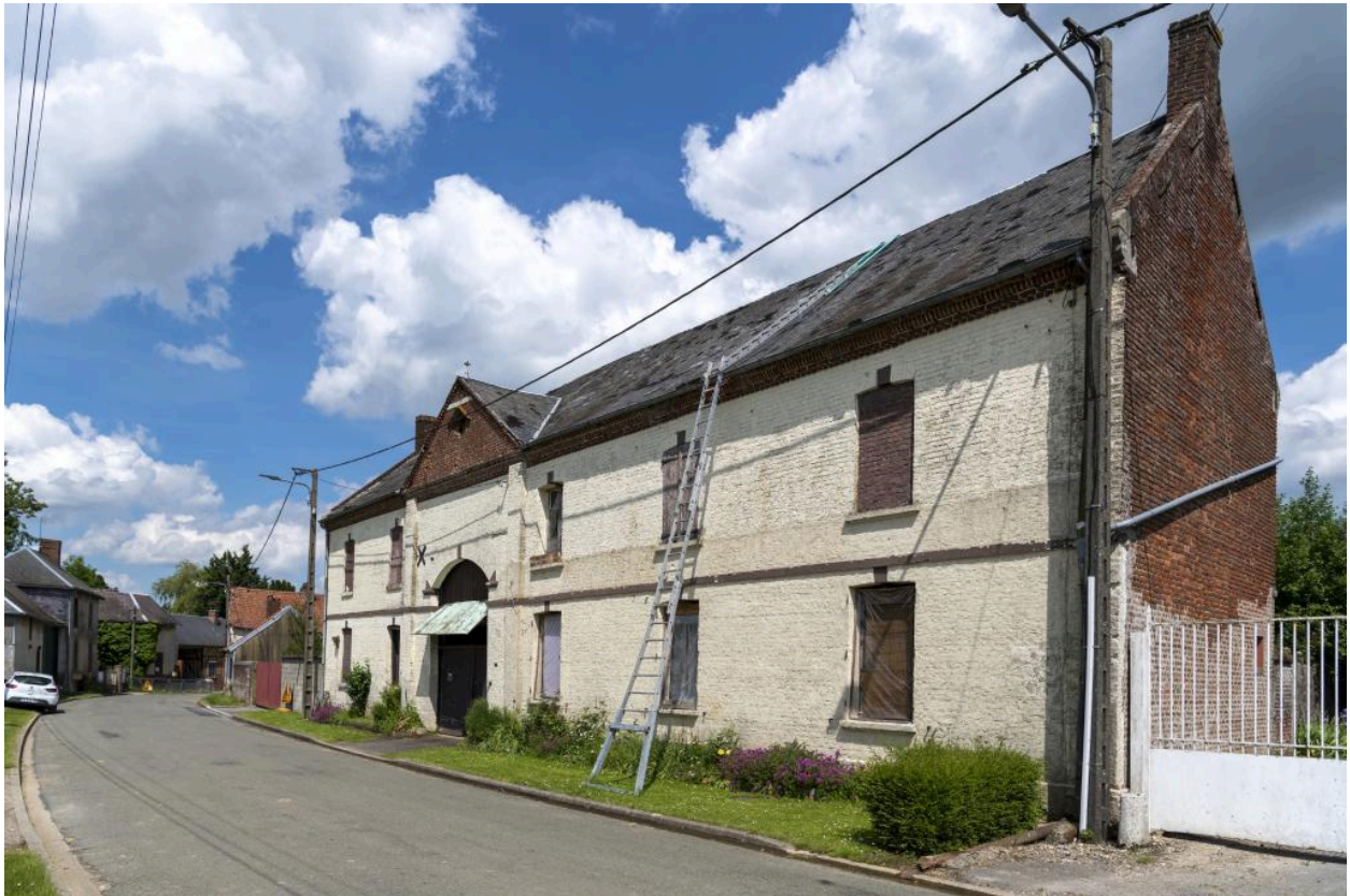
Logis de ferme sur rue, n°7 rue d'En Bas.
