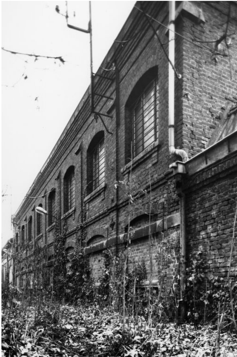
Atelier de fabrication, façade sur le canal des Teinturiers.
