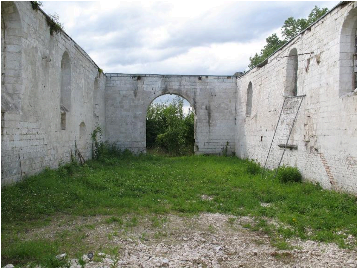
Vue intérieure de la nef, vers l'ouest.
