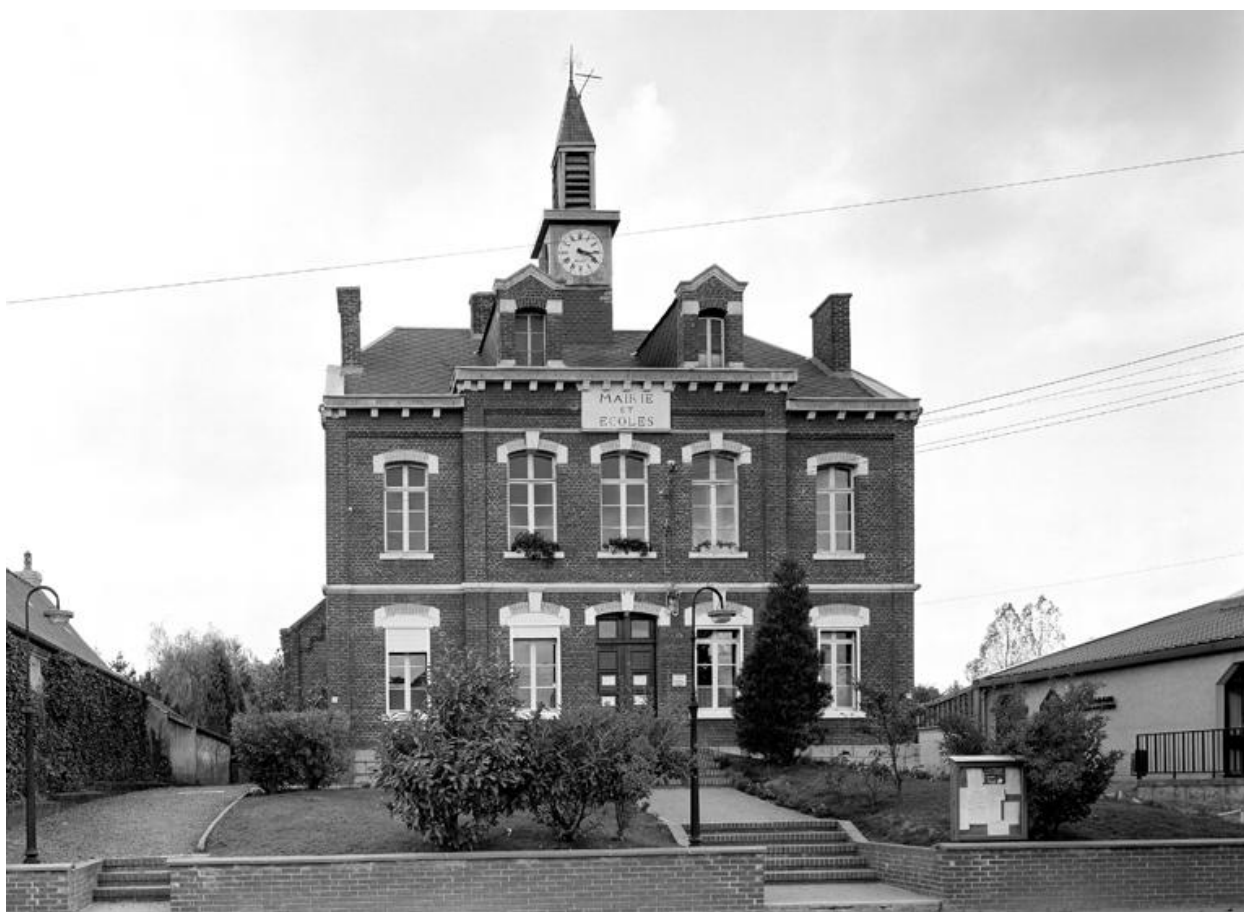
Vue d'ensemble de la façade.
