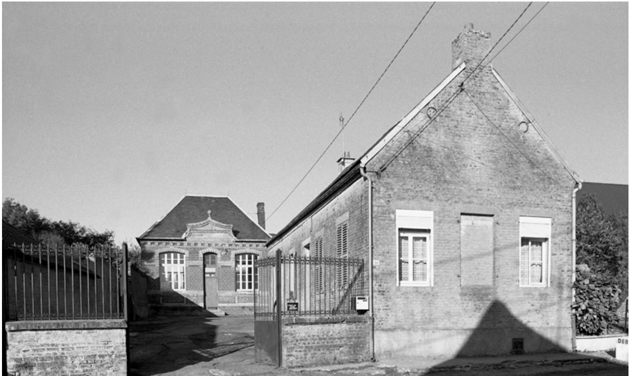
Vue d'ensemble sud-est.
