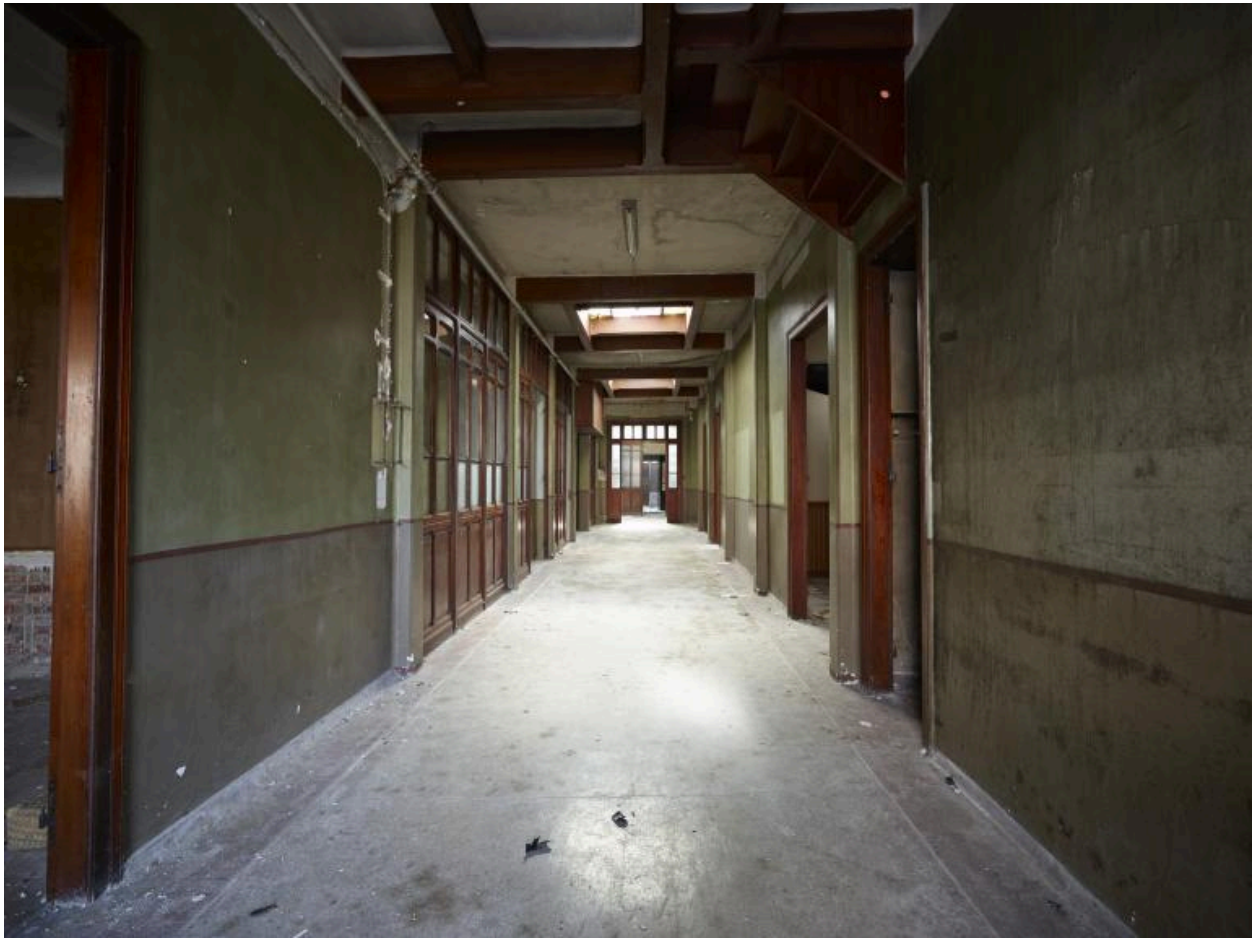
Bureaux. Couloir longitudinal vers l'ouest.
