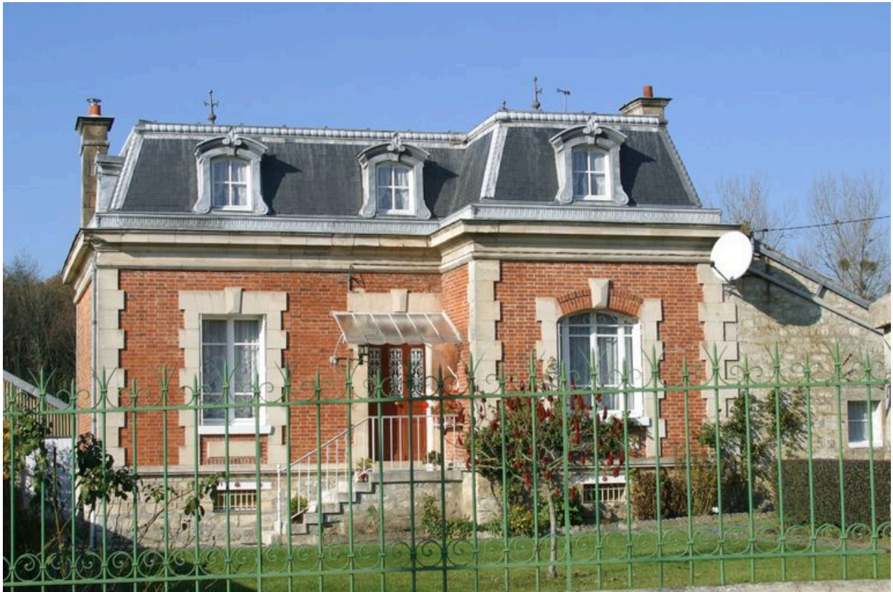
Vue générale de la façade principale.
