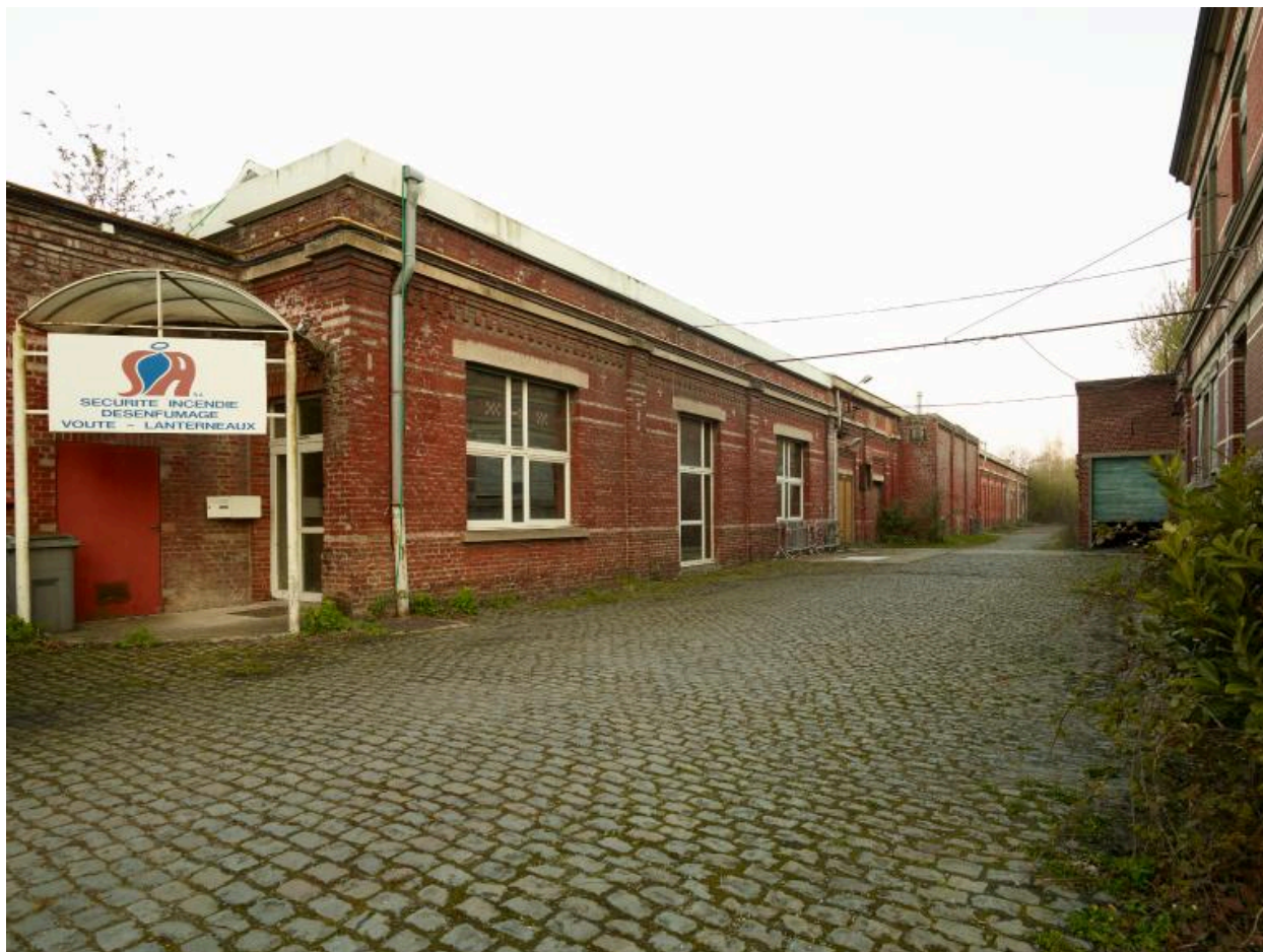
Magasin au toiles. Vue prise vers l'ouest.
