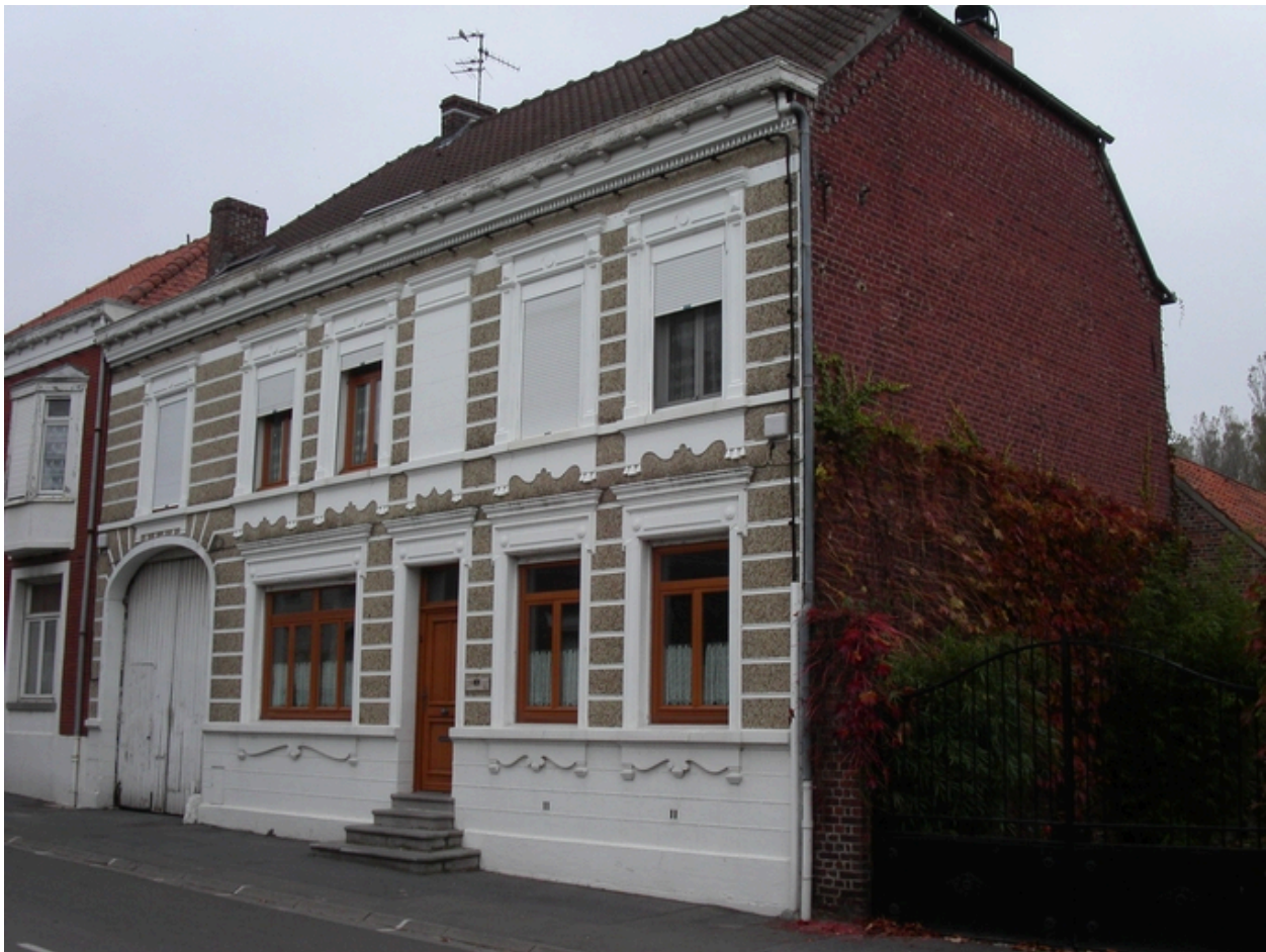
Maison d'artisan-boucher (façade en gravier roulé), 101, rue Albert-Lagache, vue depuis la rue.
