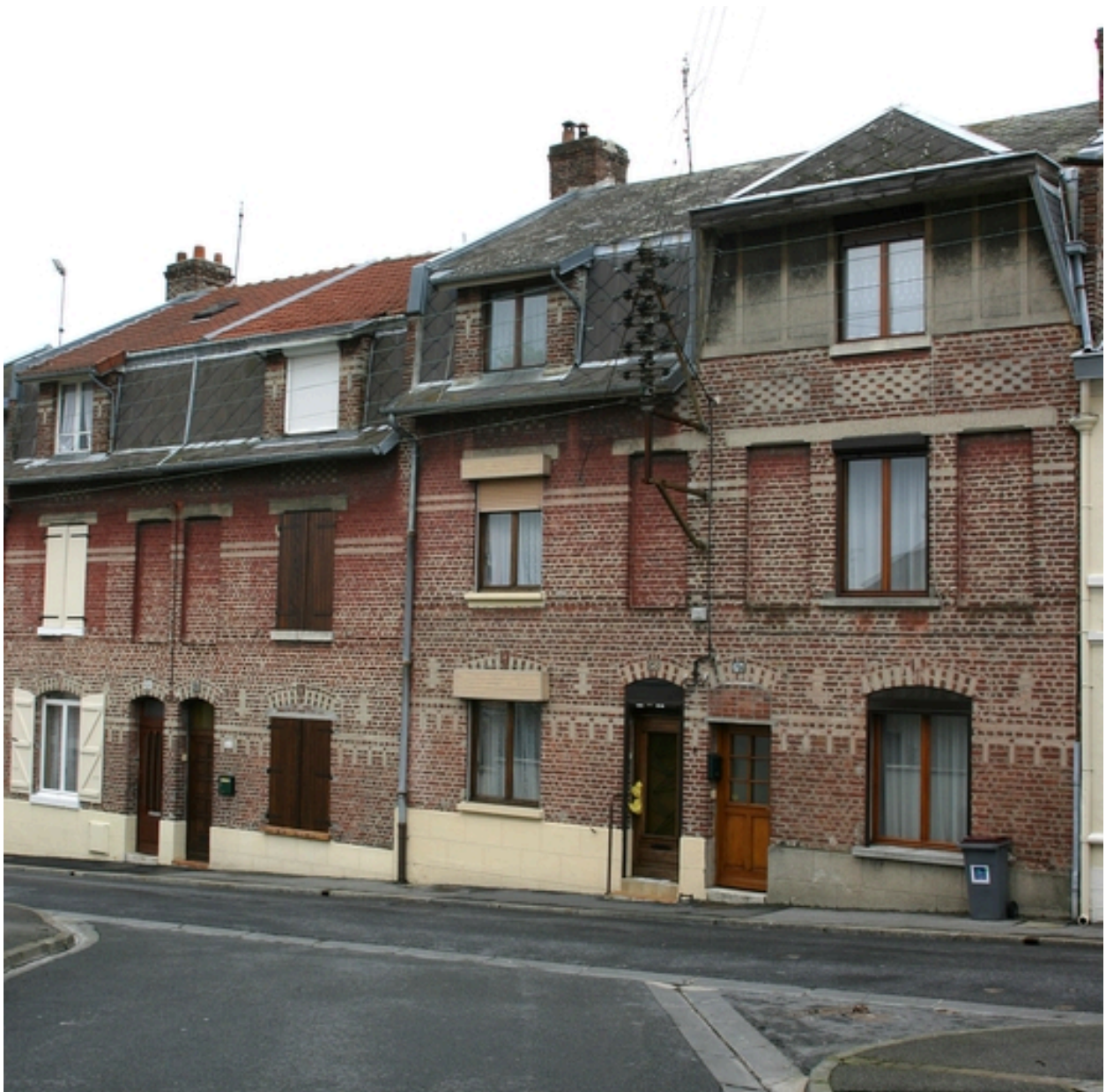
Façade antérieure de quatre des cinq logements.
