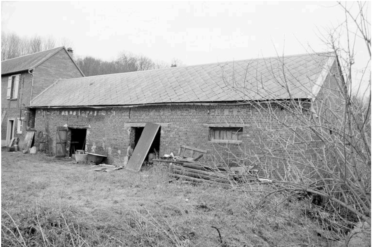
Ferme de la sucrerie : étable.
