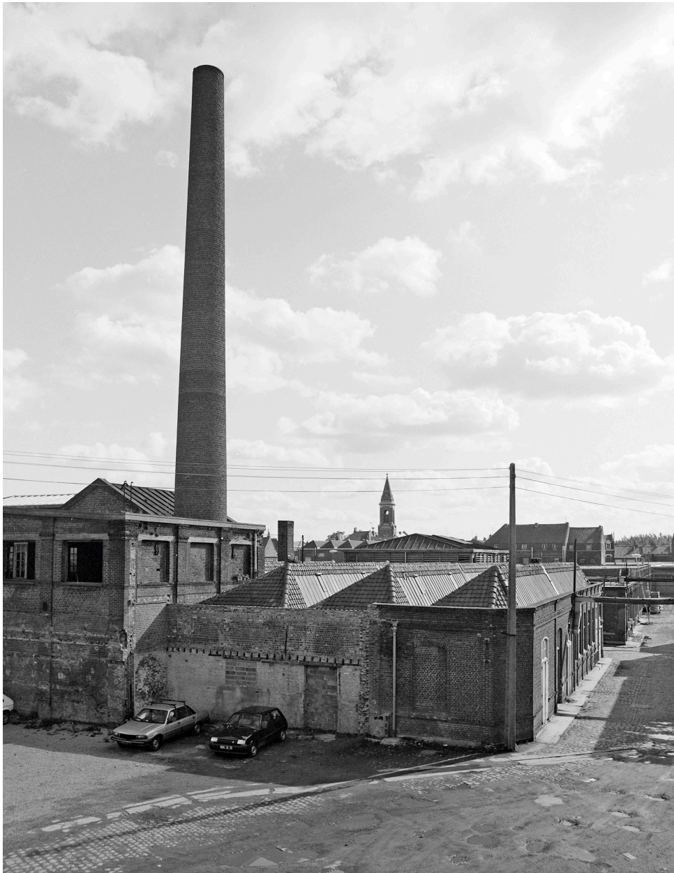
Vue générale prise vers le sud.
