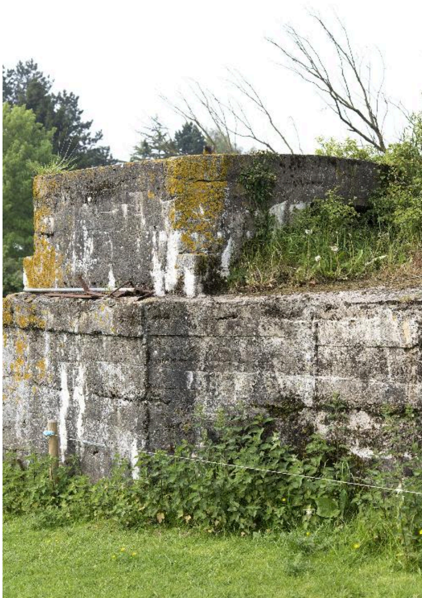
Détail du poste d'observation vers le sud-ouest
