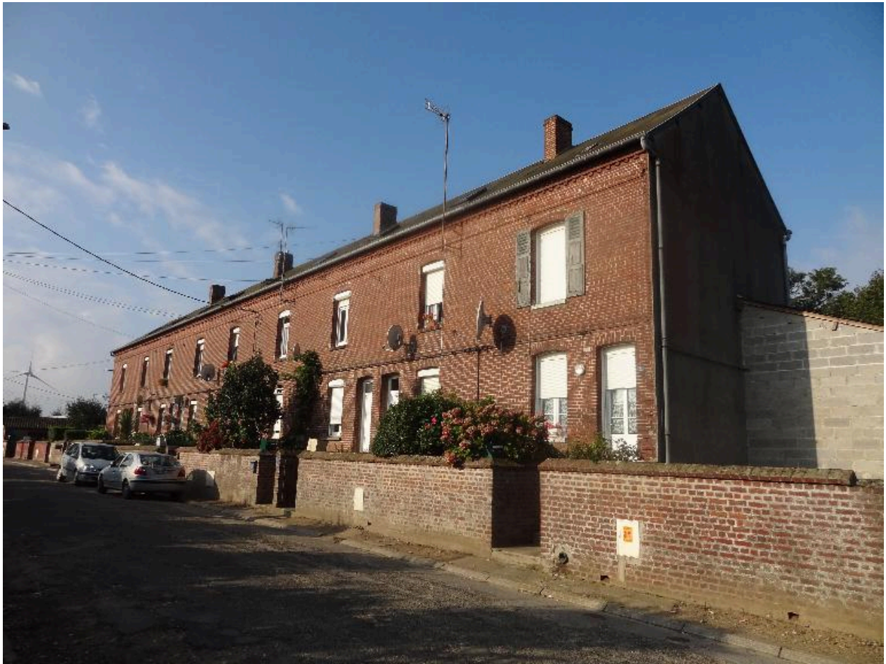
Vue de trois-quarts depuis la rue du Méneslies.
