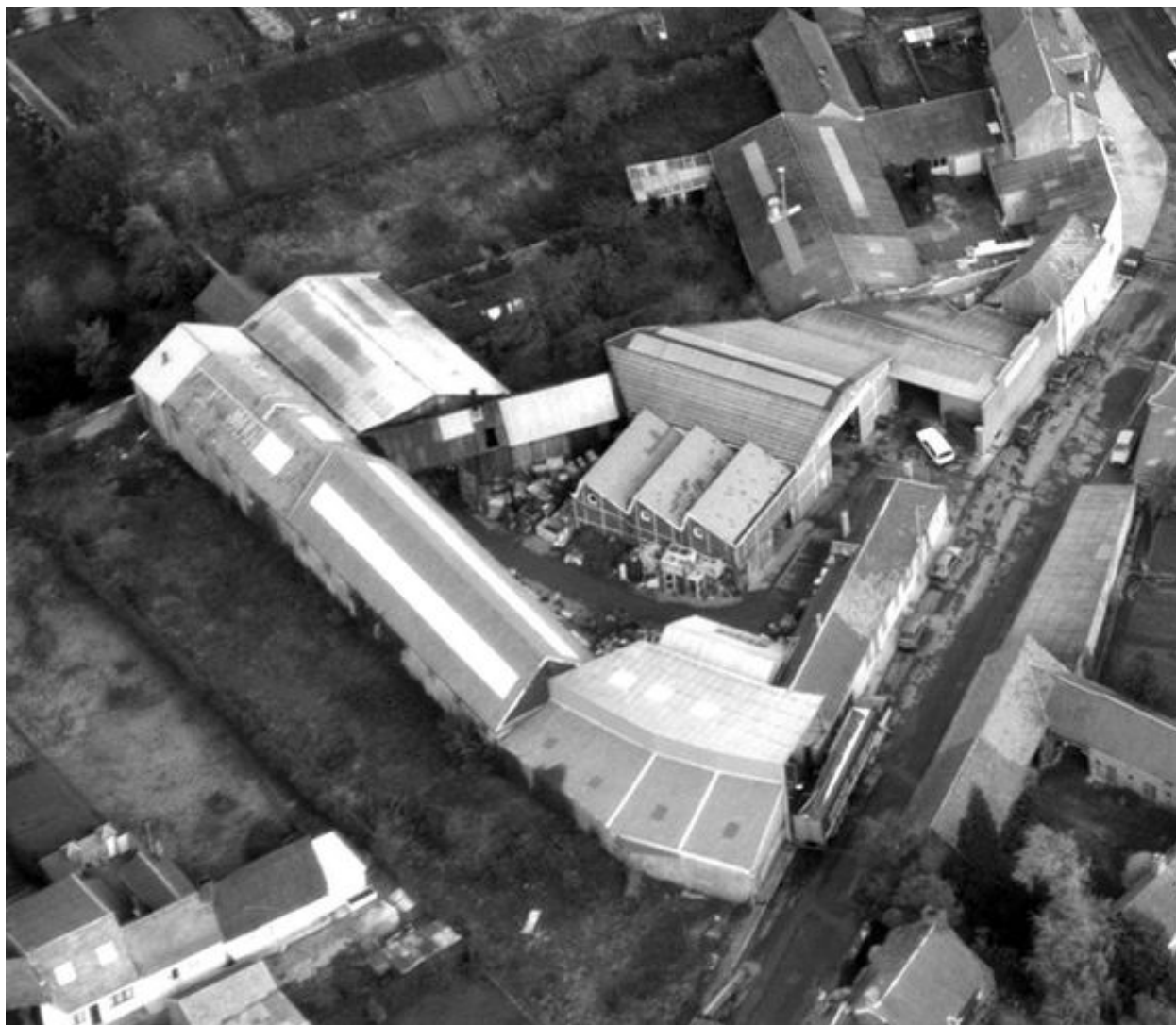
Vue aérienne, flanc sud-ouest.
